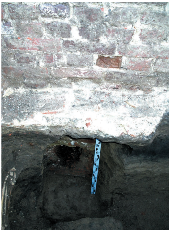
Рис. 1. Фундамент центрального придела Спасской церкви
