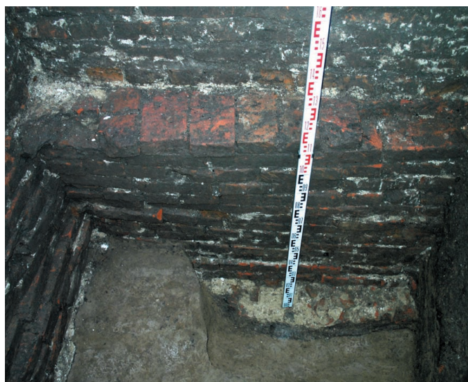
Рис. 2. Основа фундамента колокольни Спасской церкви
